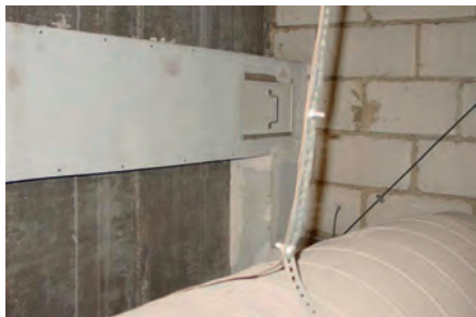
Beispiel 1: Kabelkanal aus asbesthaltigen Leichtbauplatten (Austausch der Kabel)
