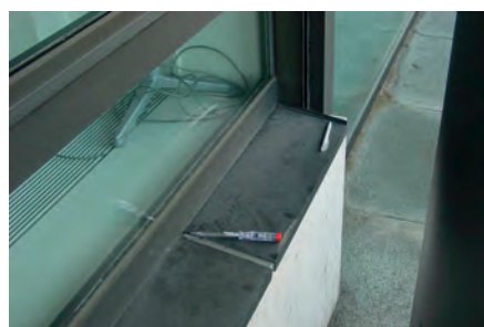
Beispiel 1: Kabelkanal aus asbesthaltigen Leichtbauplatten (Austausch der Kabel)
