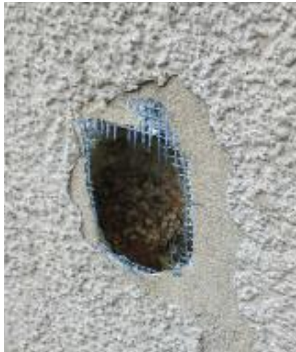
Bild 4: Schadensbilder an WDVS (Lochbildung, Putzschaden an Plattenstößen)
