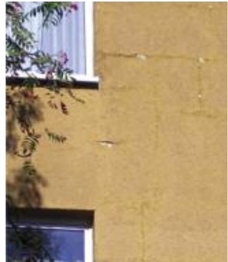
Bild 4: Schadensbilder an WDVS (Lochbildung, Putzschaden an Plattenstößen)
